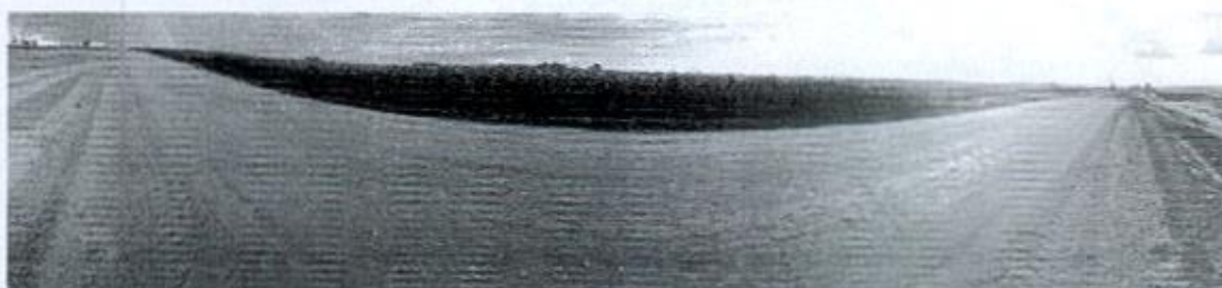
Figura 6: Trecho finalizado após acabamento com motoniveladora e rolo.
