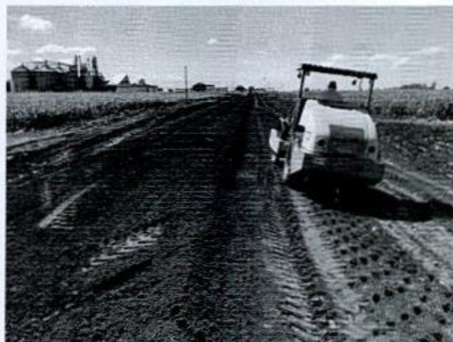
Figura 5: Compactação com rolo da estrada
